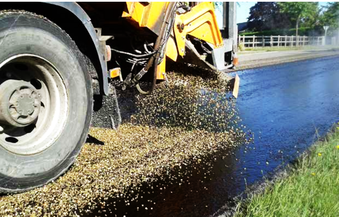
▲ Bestrijking met bitumemulsie.
