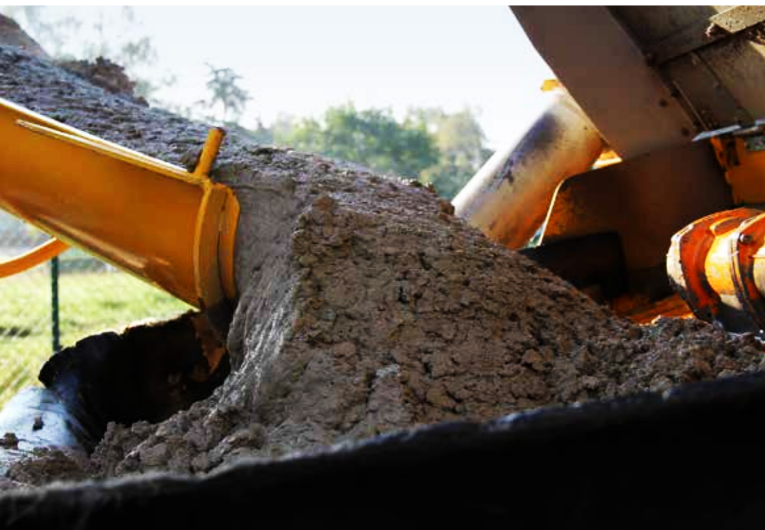
◀ Levering van beton met betonpomp.
