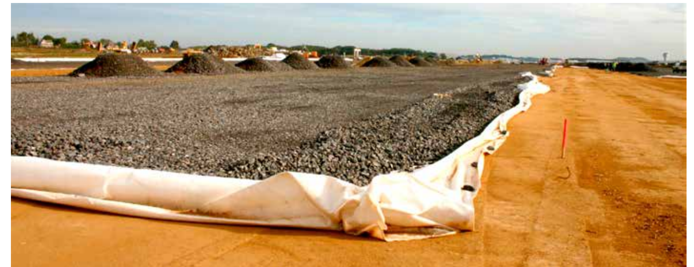
Pose d'un géotextile certifié BENOR à Bierset.
