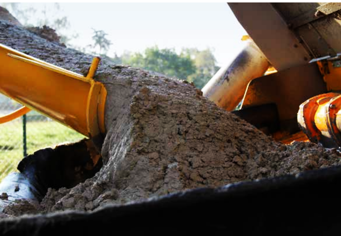
◀ Levering van beton met betonpomp.
