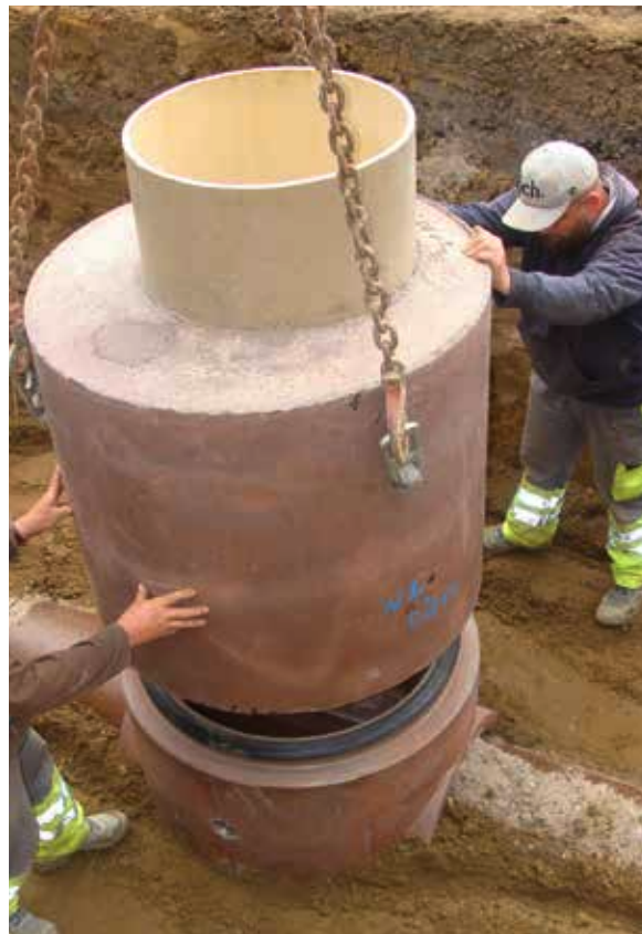
▲ Plaatsing dekelement.
