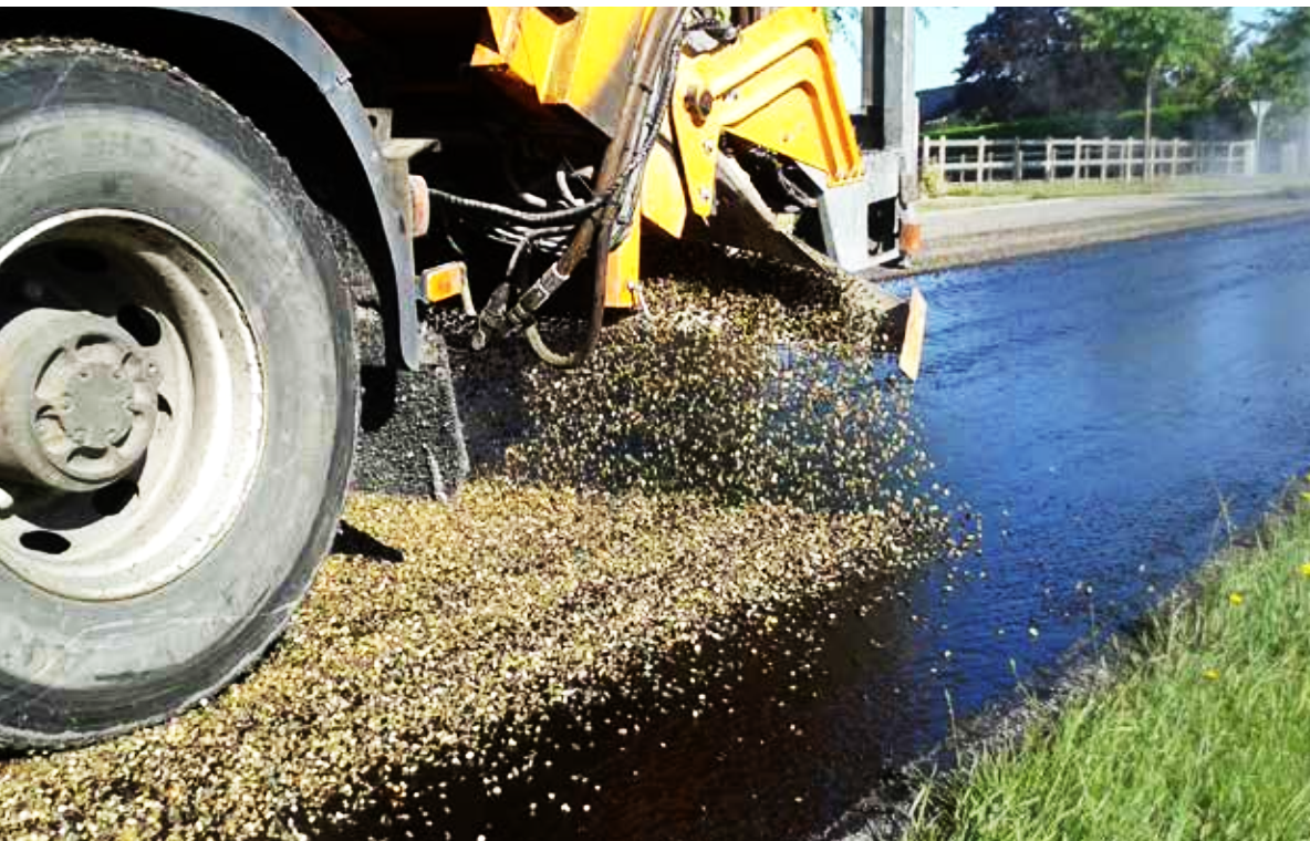
▲ Bestrijking met bitumemulsie.
