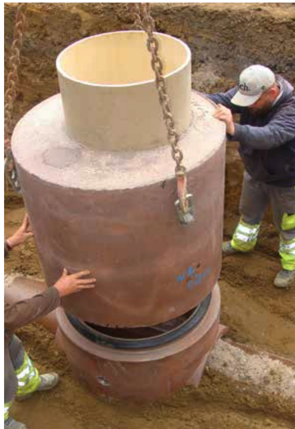
▲ Placement d'un élément de couronnement.
