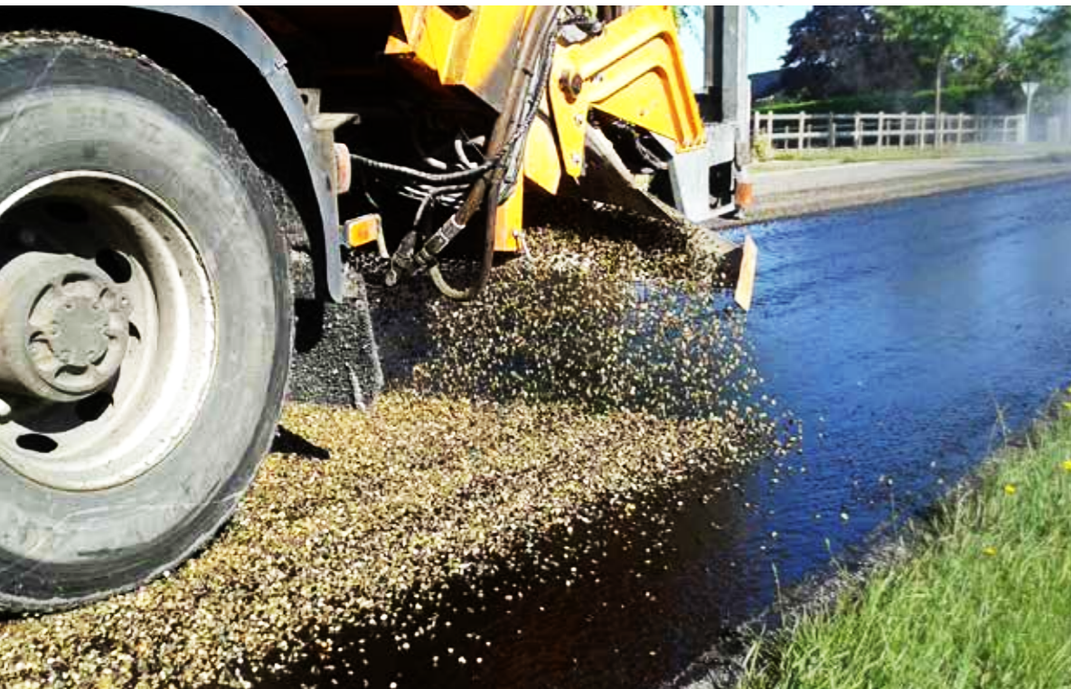
▲ Enduisage avec émulsion de bitume
