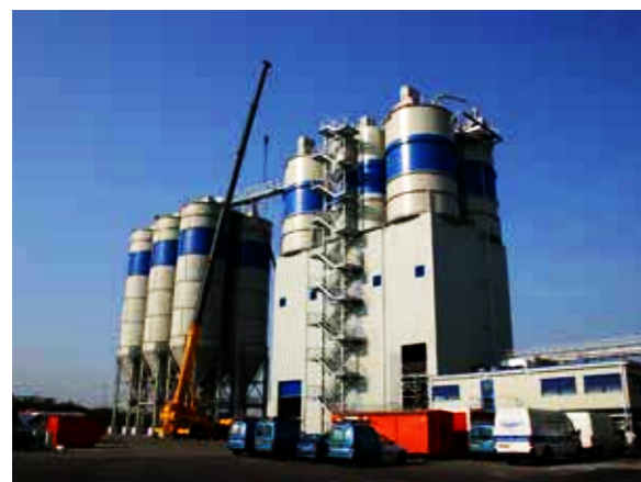
▲ Production et stockage du filler naturel.
