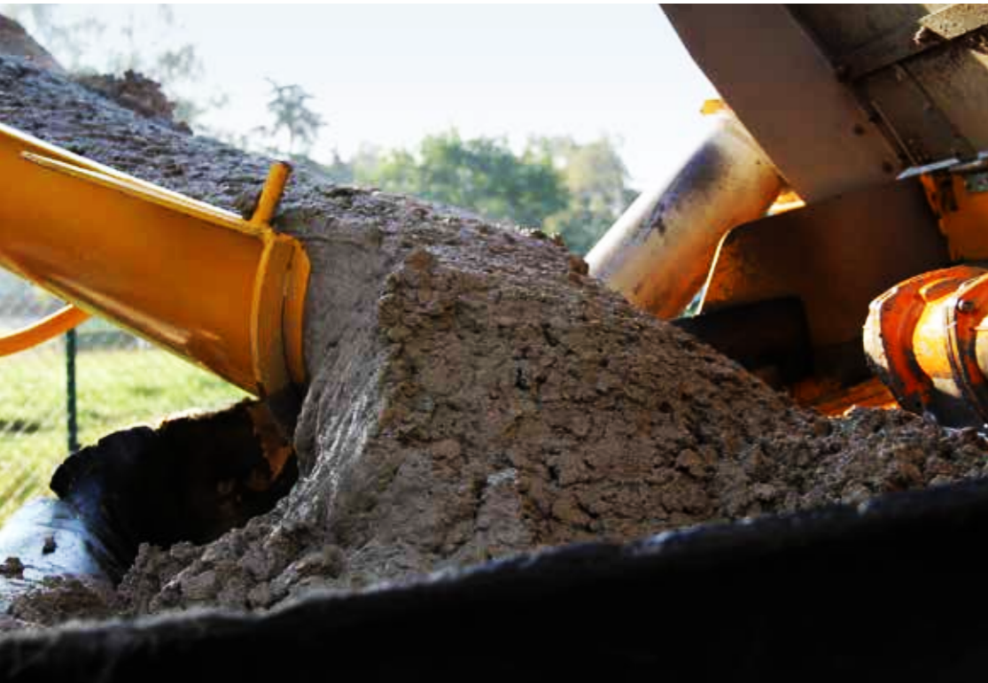
◀ Livraison du béton avec une pompe à béton.
