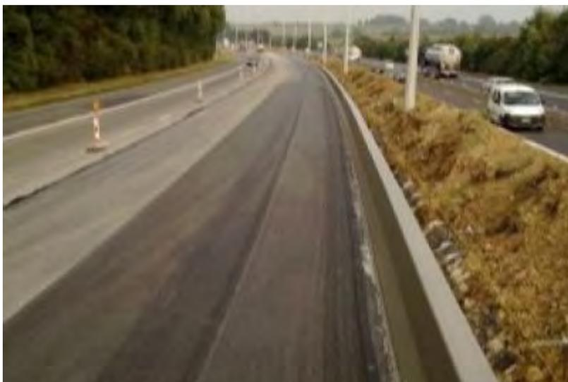
**BARRIÈRE DE SÉCURITÉ EN BÉTON COULÉ**
